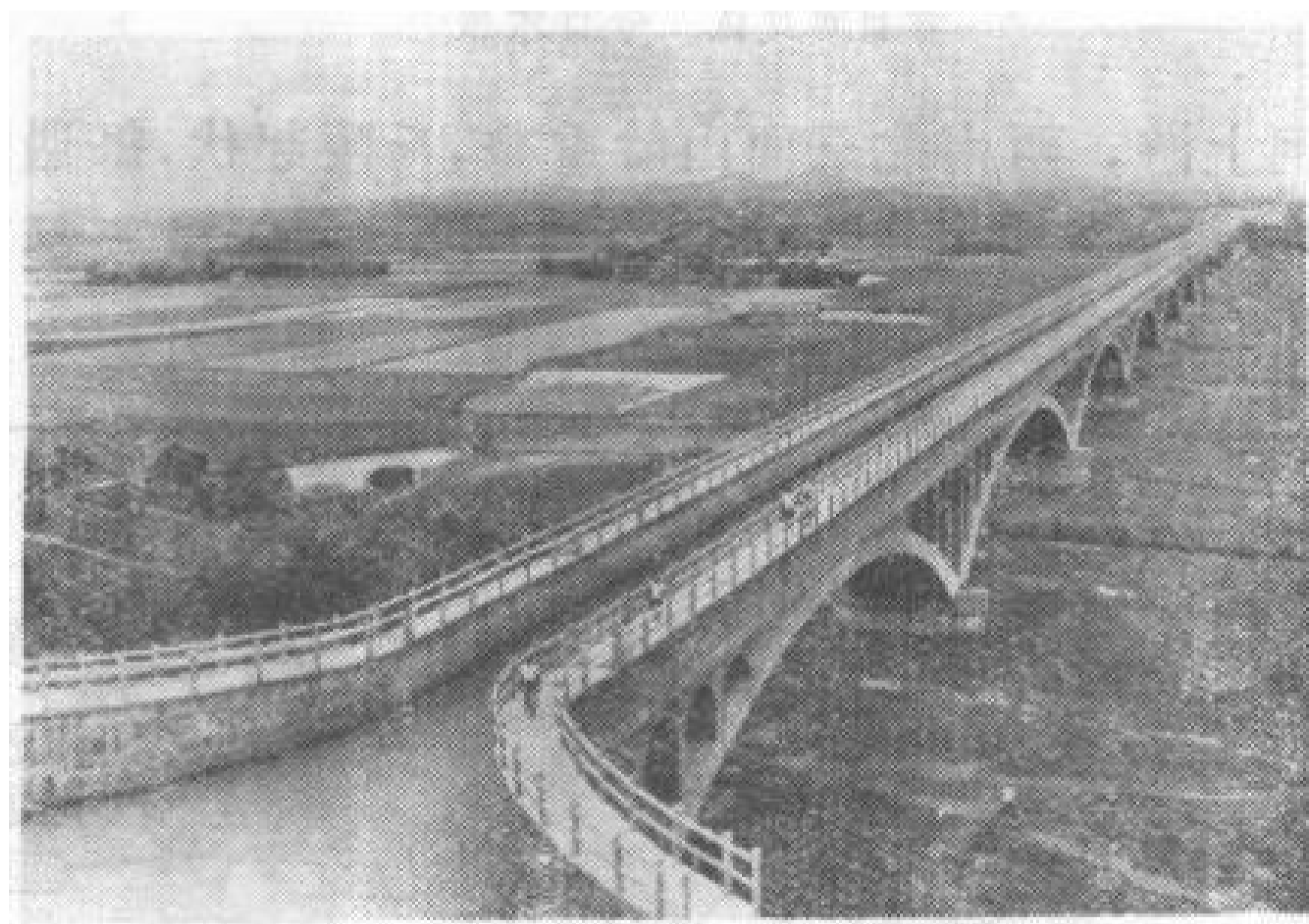
淞史杭工程的将军山渡槽
